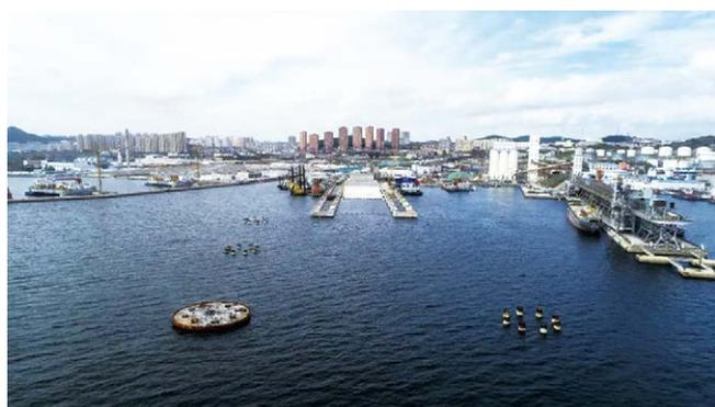
公司海隧主体结构项目部负责施工的大连湾海底隧道北防波堤恢复工程，是大连市工业遗产恢复的重点项目，工程内容为前期施工拆除的“半月形”堤身，施工长度为420米。恢复工程完成后，北防波堤将重新承担“护港”重任，保证大连港区的船只货物通行安全。
