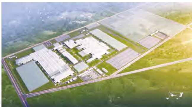
华晨宝马铁西厂区车身车间一期、冲压车间一期机电总承包项目
