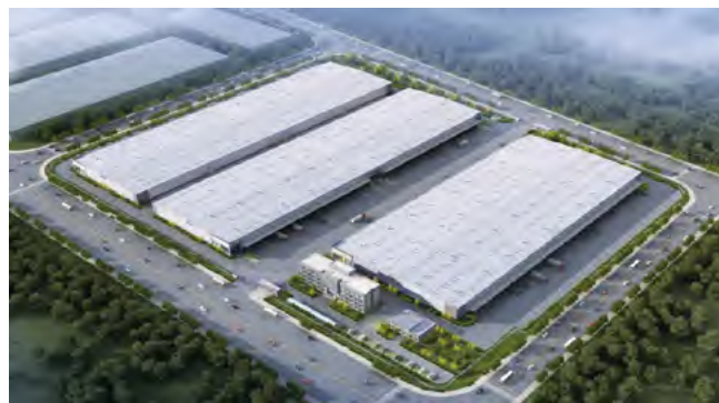
普洛斯（浑南）现代产业园四期施工总承包项目
