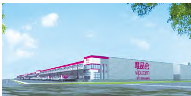
唯品会东北产业园（一标段）施工总承包项目
