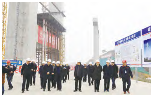
图五、参加仪式的领导来宾参观主桥施工现场
