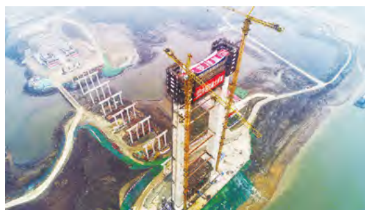
图一、空中俯瞰大桥北索塔；（王成龙航拍）
