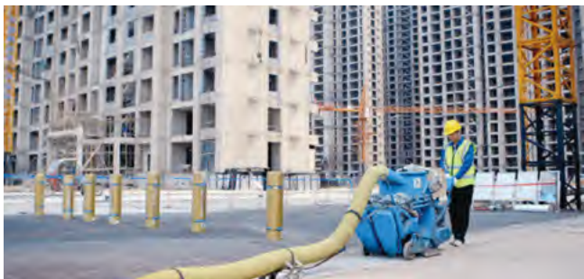
图3 基面抛丸处理
