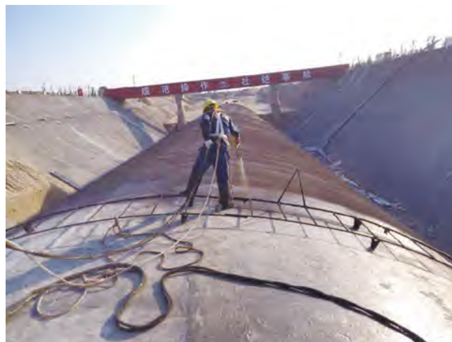
图三 大面积喷涂施工
