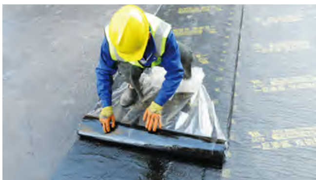
图8 铺贴防水卷材
