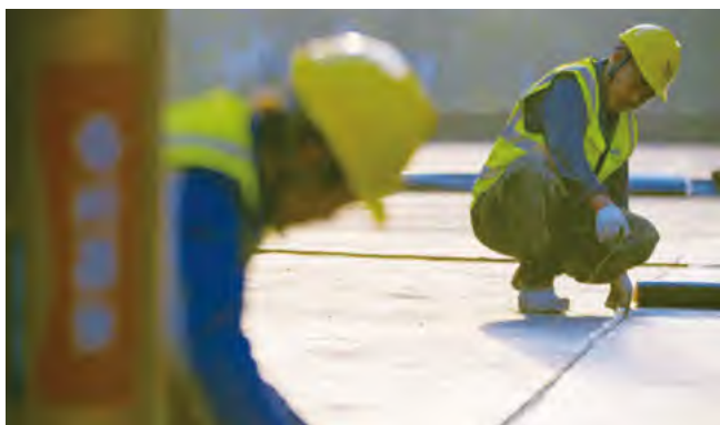
图6 定量控制-分格、弹线
