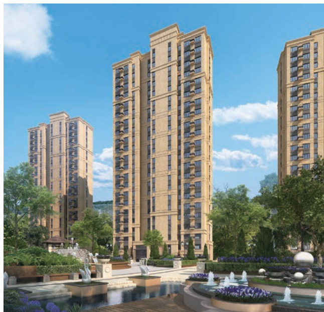
天津武清凤河二期项目公共区域及室内精装修工程
