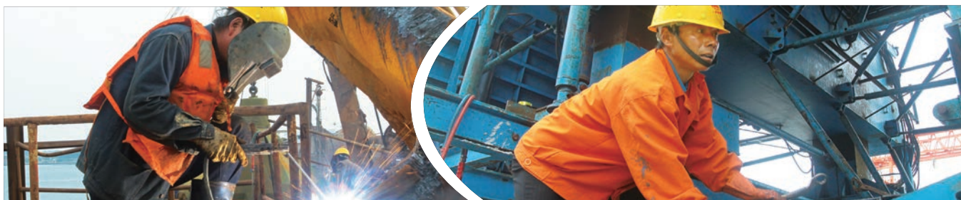
工人在焊接打桩锤锤牙
