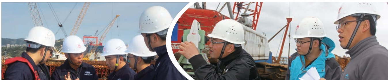
一公司项目部管理人员在现场研究施工
