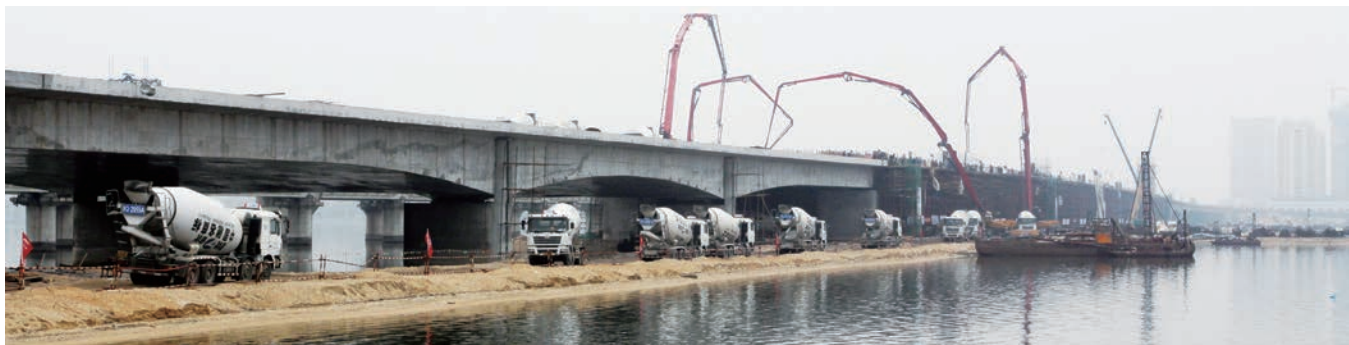
图为大桥施工现场
