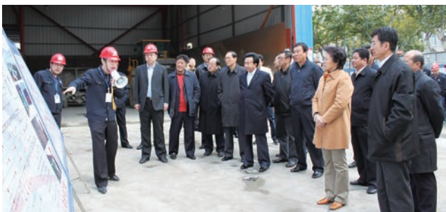
中铁一局工地接受大连市人大检查，项目经理李非现场汇报
