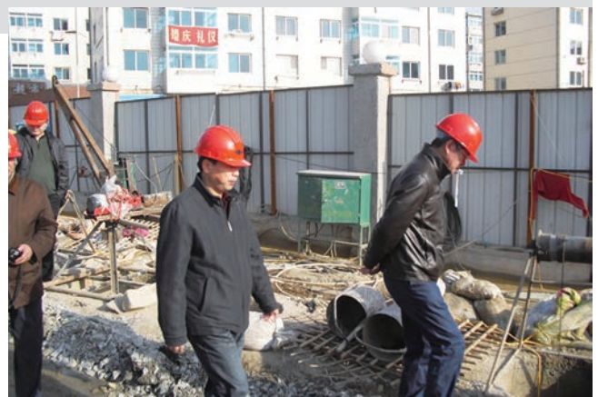
巡视桩基施工
