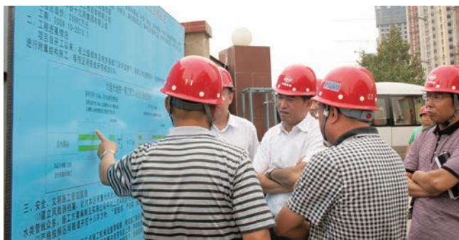
市建委领导视察工地
