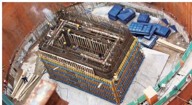
主塔第一节段模版拼装
