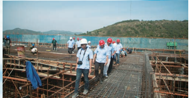
参观顶层作业面
