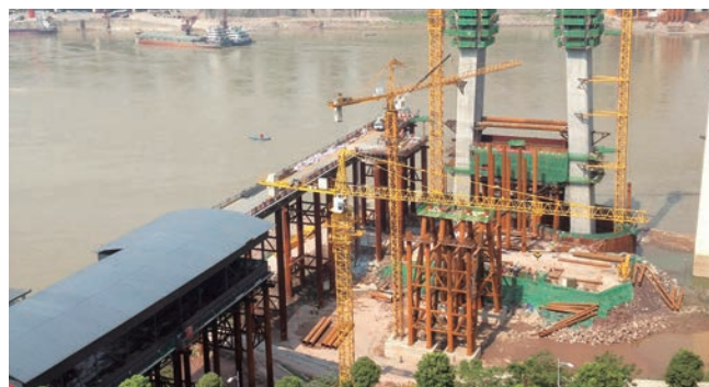
大桥施工全景
