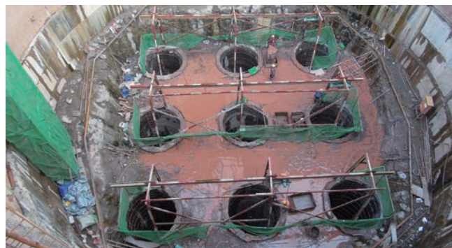
主塔承台桩基础施工
