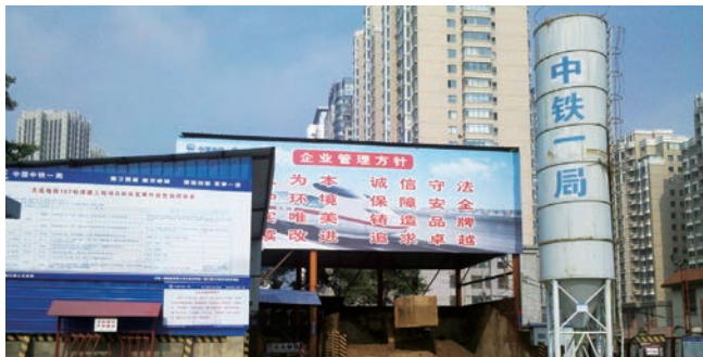
中铁一局现场标准化场地
