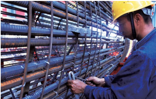
钢筋绑扎作业
