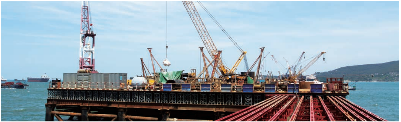
海上平台钻孔桩施工
