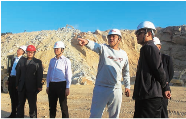
公司福平项目经理蔡维栋（右二）和项目书记张叙东（左三）在施工现场
