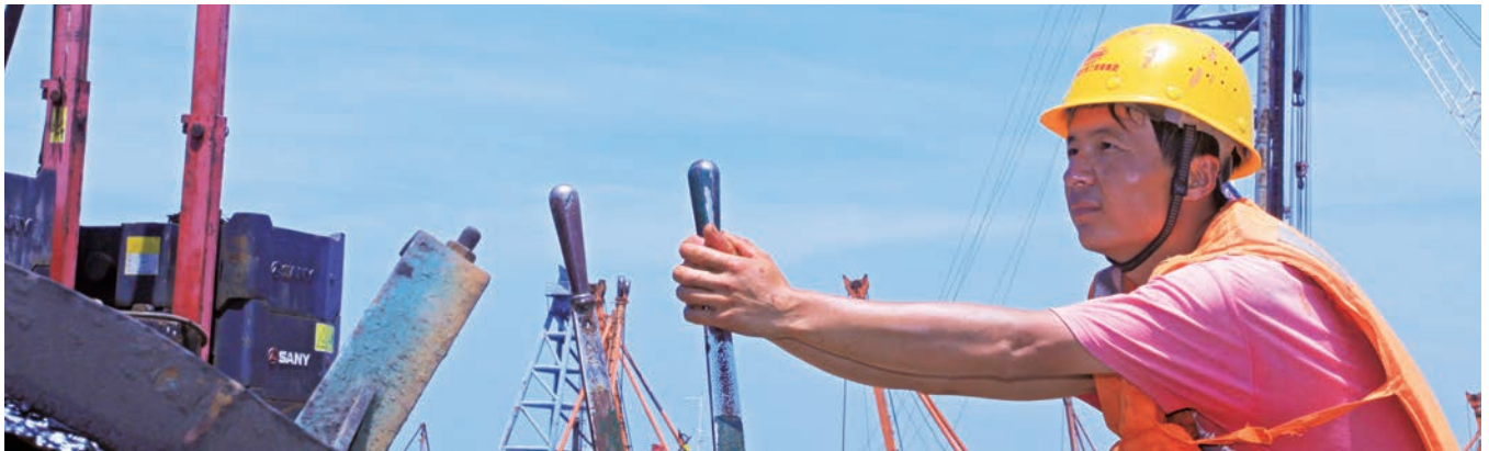
钻机手施工作业
